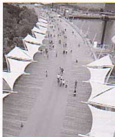
長久手会場にある空中回廊はグローバル・ループと呼ばれ長さ2.6km、幅約21m
